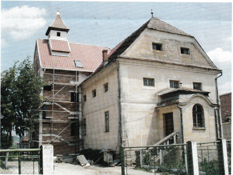
Ungewohntes Bild. Pfarr- und Gotteshaus im Umbau. Hier Zustand vom Spätsommer 2003. Foto: Kristian Krause
